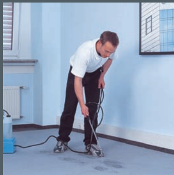
Nebelfeuchtes Auftragen des FDT®-Enzymreinigers
