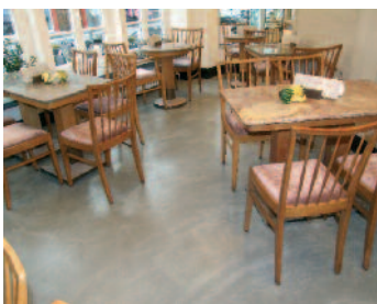
PANDOMO®-Steinboden als Spachtelboden. Abgesiegelt mit PU-Lack
