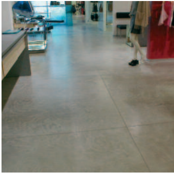
Shopböden mit einem ZRN-Sichtestrich in Kornspitzoptik angeschliffen
