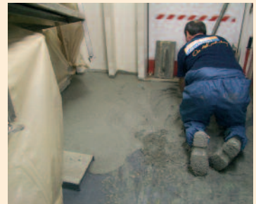
Einbau des Schnellestrich-Systems in der Wäscherei
