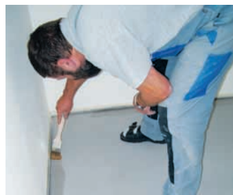
Ob Fußböden, Wände oder Decken – die Facharbeiter von zebo verstehen ihr Handwerk
