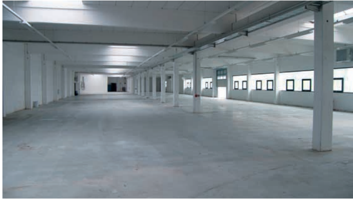
Fertig verlegter Industrieestrich im Lager- und Versandbereich der Halle.
