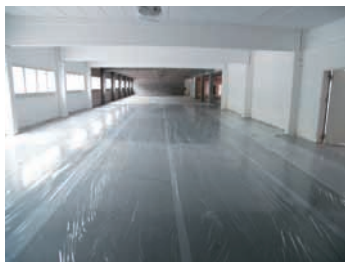
Die Folienabdeckung als abschließende Nachbehandlung verhindert ein zu schnelles Austrocknen des Estrichs.
